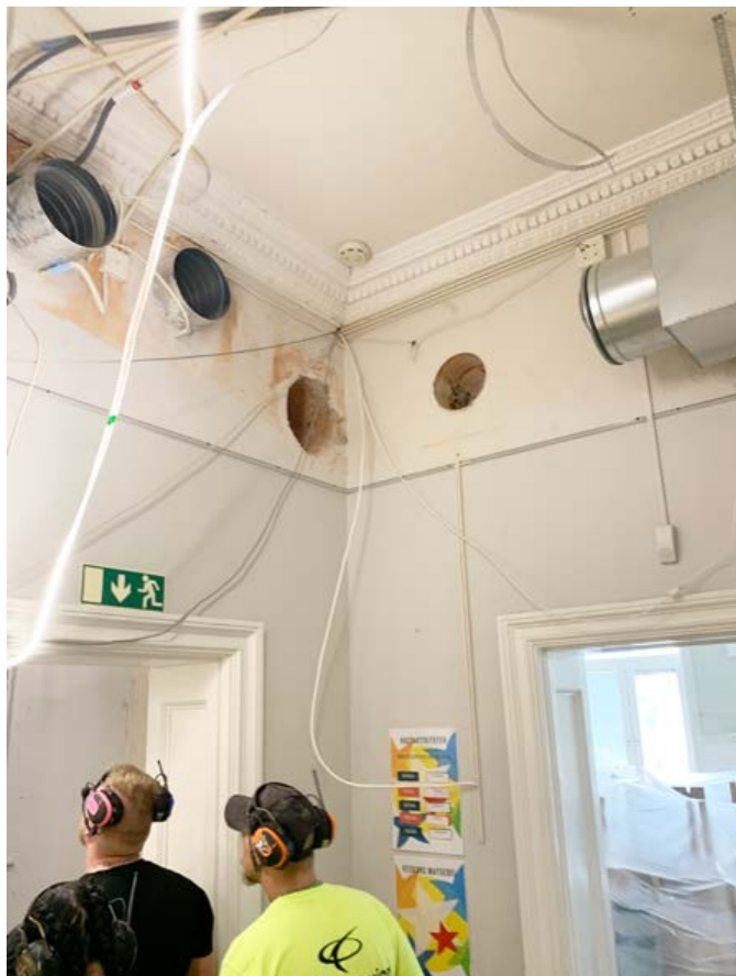
En konsekvens av moderna krav blev att nära 100-tals genomföringar i betongvägg fick göras för kanaldragningarna.
